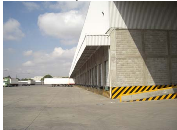
Patio de Maniobras
