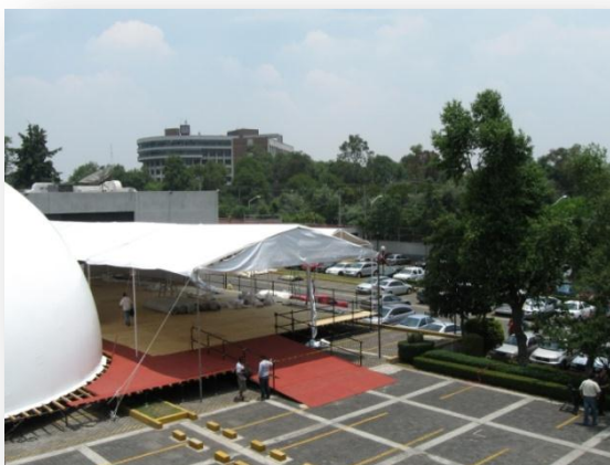
Edificación de la Macrosala
